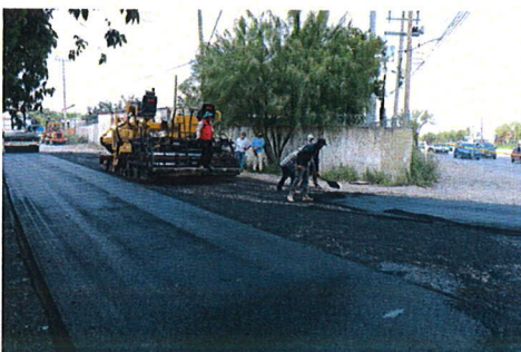
Varias de las calles principales se repavimentaron para mejorar la vialidad.
